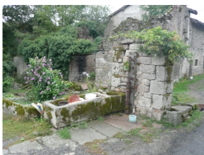
14. Fondanèche : puits, pompe à eau
